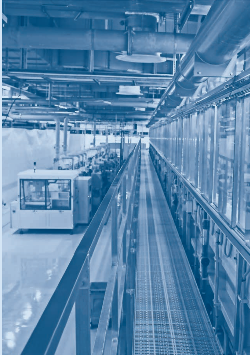
INSTALLATION DER NÄCHSTEN TECHNOLOGIEGENERATION IM KERNGESCHÄFT: MSAP-PRODUKTIONSLINIEN AM STANDORT SHANGHAI.
